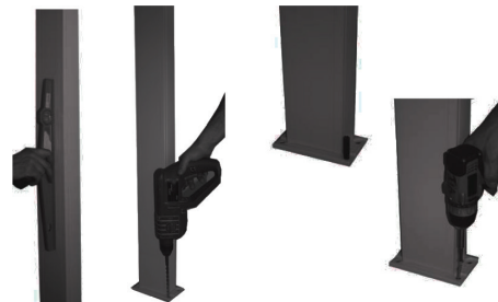
2 - Fixation du montant: Percer votre support et adapter votre fixation
