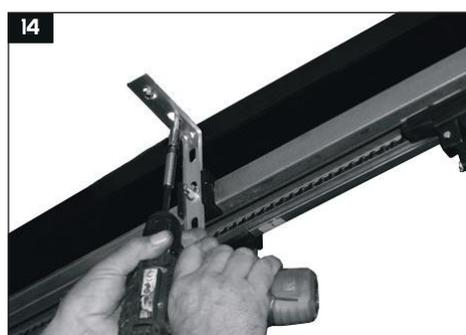
Fixez les pièces A au plafond avec les pièces P, O et I
